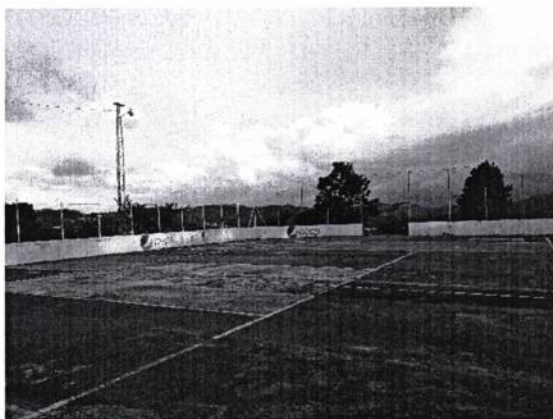
Fotografía N° 2. Vista interior 1 Cancha Multiusos
